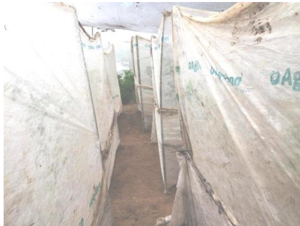
Fig. 3 Finalización de instalación de agribón.
