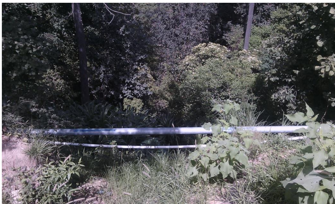
Fotografía 12: Tubería del sistema de agua potable en la aldea Xequemeyá.
